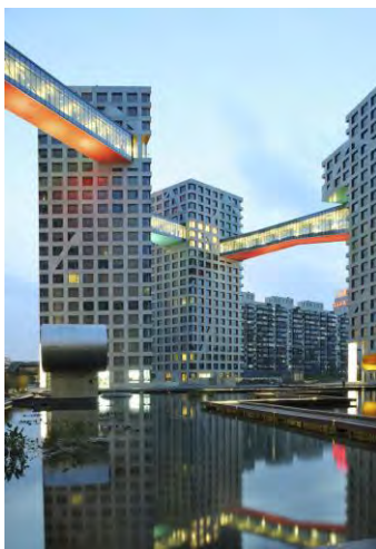
EDIFICIO HÍBRIDO. STEVEN HOLL
